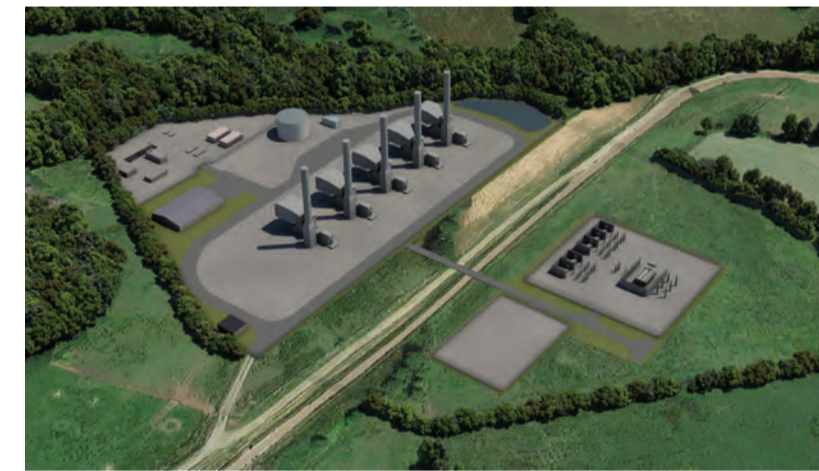
Delweddau enghreifftiol o'r Prosiect. Seilir y delweddau hyn ar waith cynhyrchu pŵer yn cynnwys pum generadur tyrbîn nwy. Os bydd angen llai o unedau, gallant gael eu hwylo (ond ni fydd uchder y simnelau'n cynyddu).
